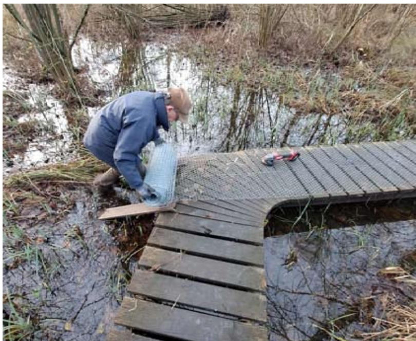
Plaatsen anti-slipgaas op vlonderpad – foto: Gie Wyckmans
