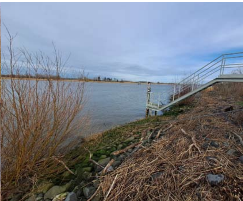
Uitwateringsluis Vliet kant Schelde – foto: Erik De Keersmaecker
