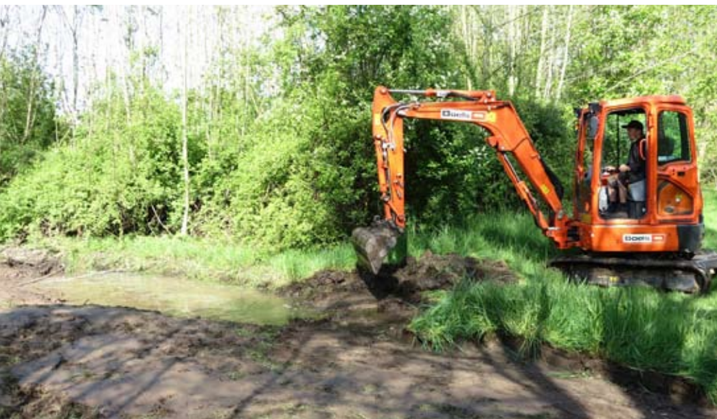
Graafwerken door Thomas – foto: Francis Mertens
