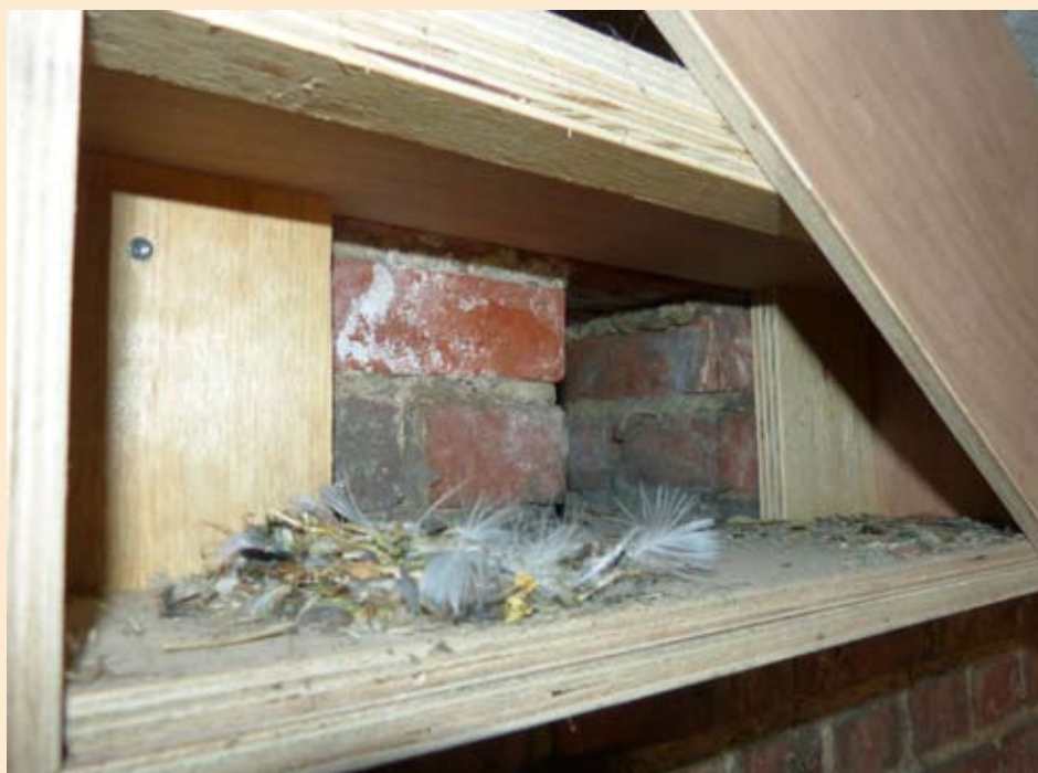
Controle gierzwaluwnestkast achter muurgang torenuurwerk H.Hartkerk Boom na de broedperiode foto: Erik De Keersmaecker
