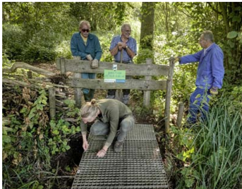
Plaatsen nieuwe wandelbrug in het Niels Broek door Jan, Harry, Yente en Jos foto: Erik De Keersmaecker
