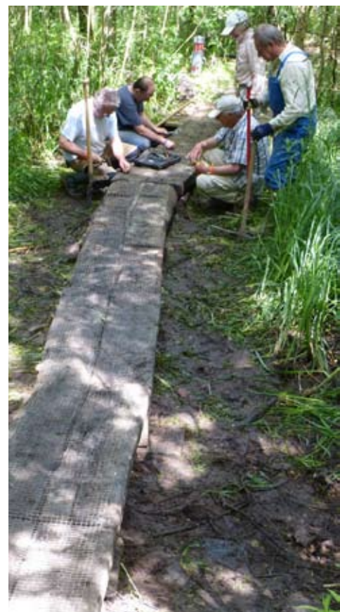
Beeld uit 2012, bouw wandelbrug over brede sloot in de oude kleiputten Boom/Terhagen door vrijwilligers Natuurpunt Rupelstreek – foto: Erik De Keersmaecker
