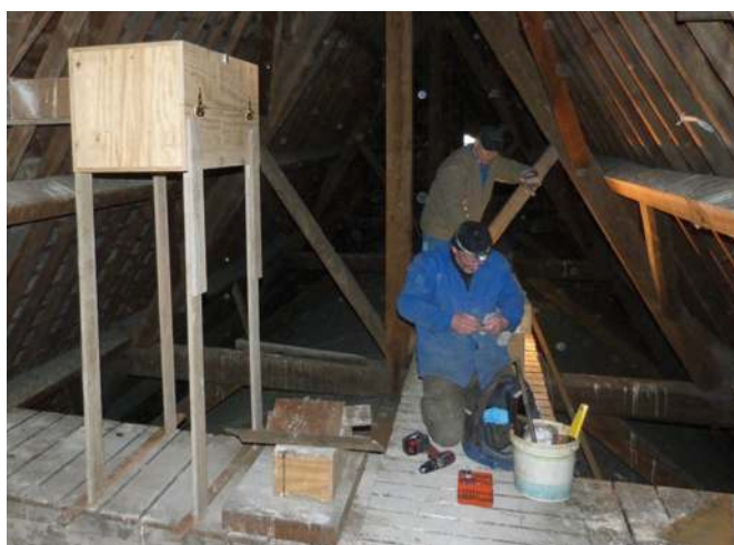
Plaatsen nestkast kerkuil kerk Hellegat
